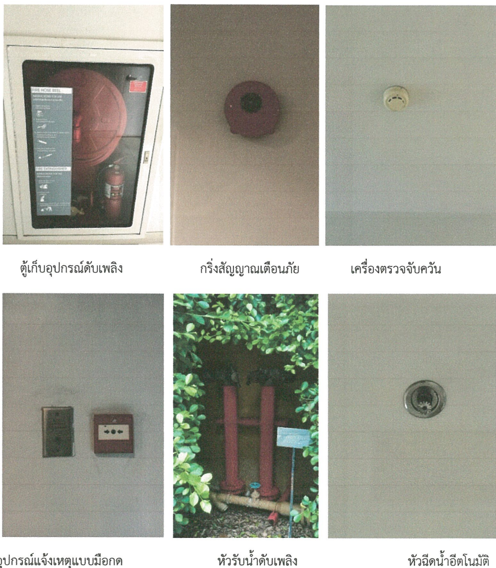
รูปภาพที่ 2.37 ระบบป้องกันและเตือนอัคคีภัย
