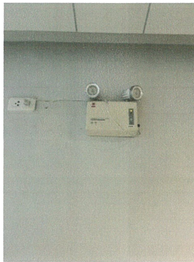
รูปภาพที่ 2.22 ไฟสำรองฉุกเฉิน
